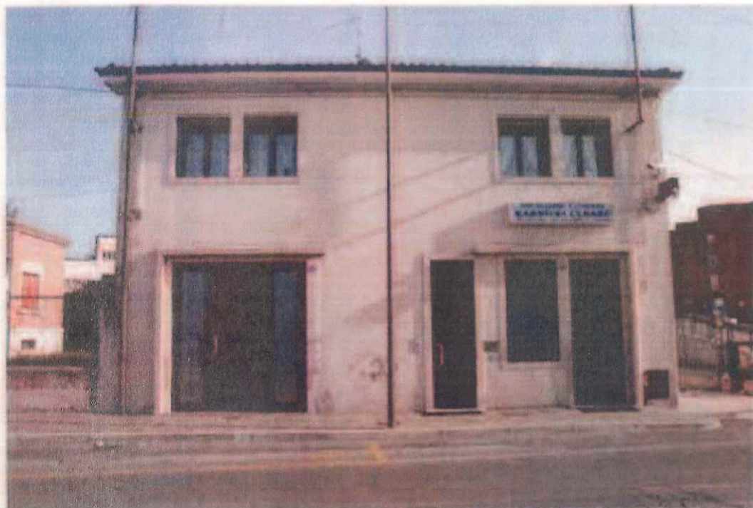
FOTO N° 1 - PROSPETTO PRINCIPALE SU VIA PREDICALE
